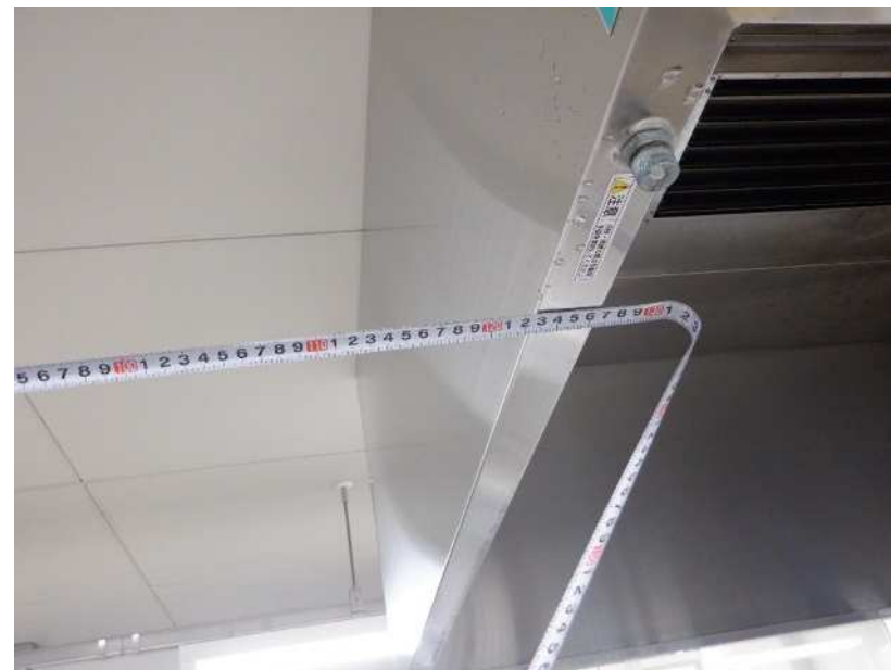
↑ 入口と出口の上部に天井扇あり。天井扇の距離1220mm
