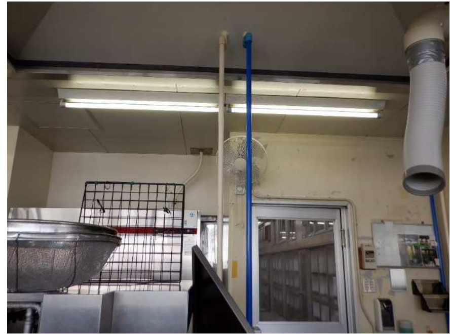
↑ 給水・給湯配管目立った劣化等なし
