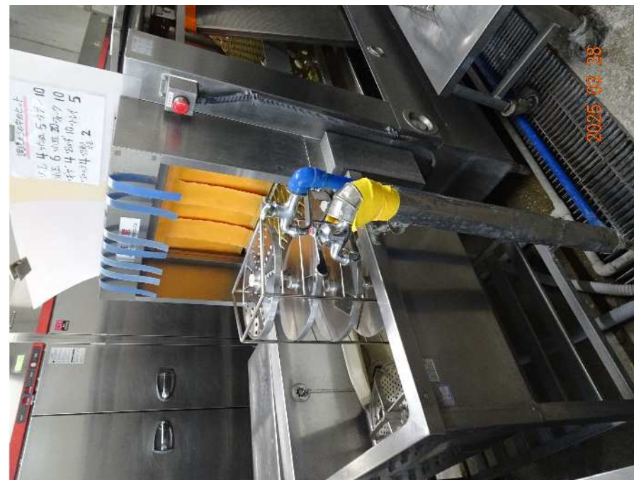
給水・給湯管が地面にあるので洗浄しにくい→洗浄機上部へ
